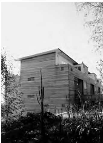
Abbildung 6: Fensterlose Fassade gegen Osten.
